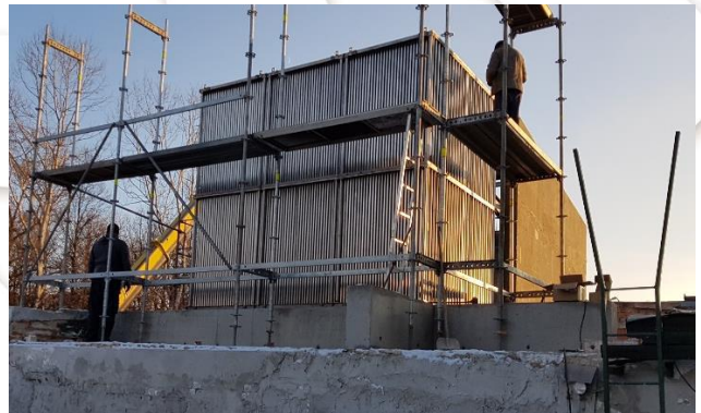
Montáž vertikálního rekuperátoru typu „4 S-TRV“
