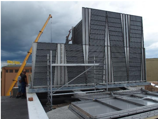
Montáž horizontálního rekuperátoru typu „2,5V“
