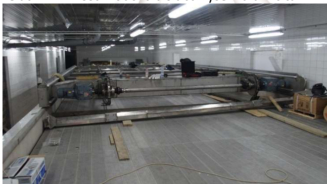
Montáž HPO u zákazníka – část 2
